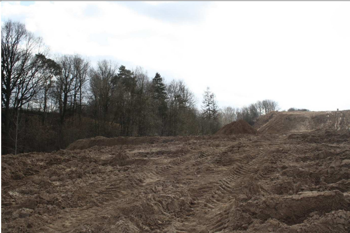
Plac budowy autostrady, w dalszym planie grąd zboczowy
