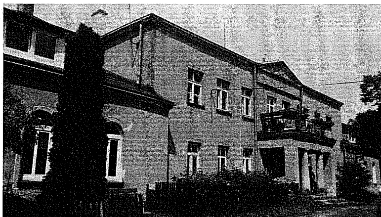
Zdjęcie 1. Budynek komunalny w Klęczkowie
