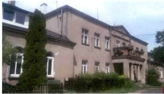
Zdjęcie 1. Budynek komunalny w Klęczkowie
